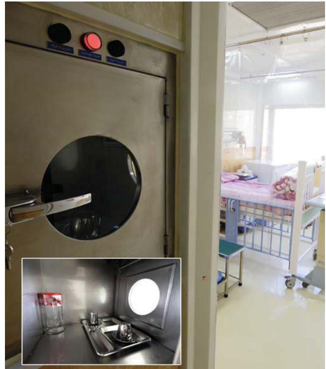
Pass Box (محفظه‌ای جهت استریل کردن کلیه وسایل و مواد ورودی به اتاق کودک)
