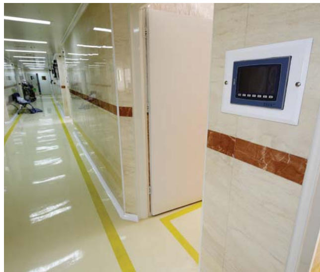
سیستم کنترل کننده حرارت، فشار و رطوبت هوای اتاق بیمار
